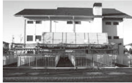
黒瀬ポンプ場
