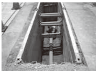
汚水管を布設している作業
