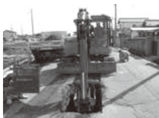
汚水管布設個所の掘削
