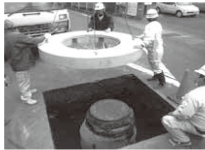
マンホール浮上対策工事
